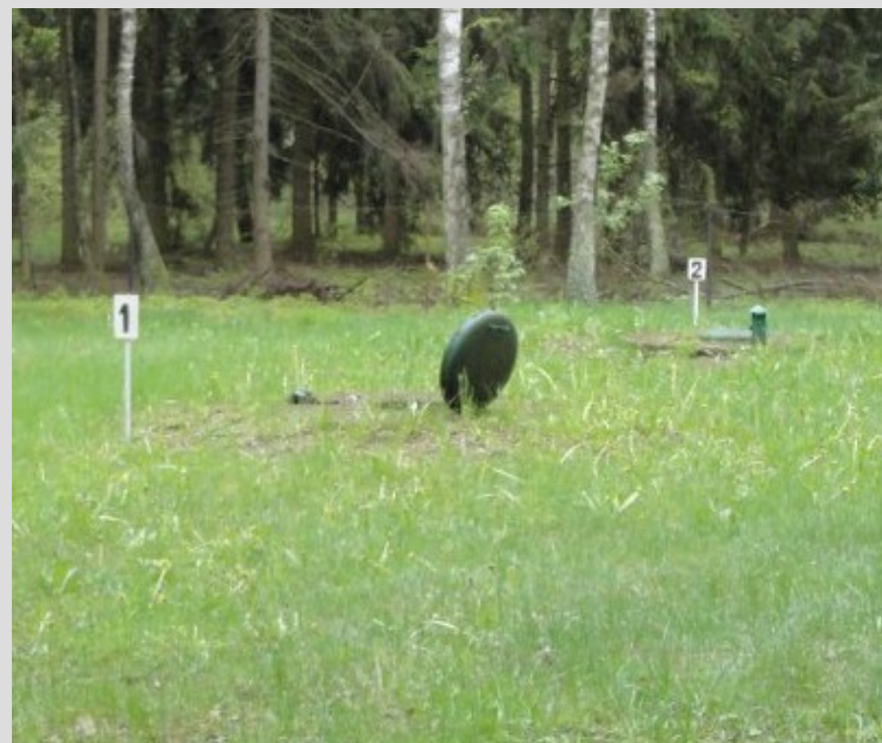
Wymiana pompy głębinowej w hydrofornii Napierki – 10.857,07 zł
